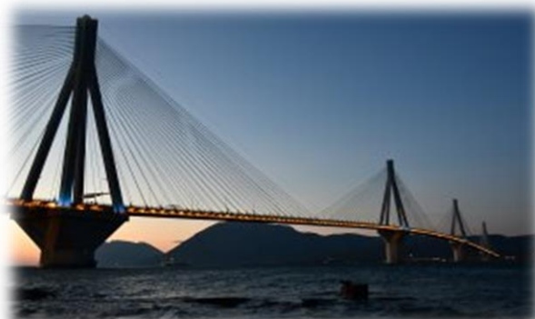
Εικ. 26: Γέφυρα Ρίου -Αντιρρίου
